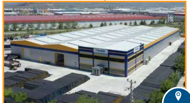
Koruge Sistemleri Üretim Tesisi
