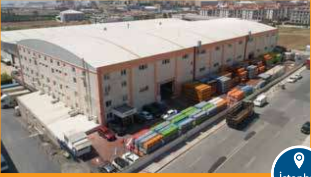
Vana ve PP-R Sistem Üretim Tesisi
